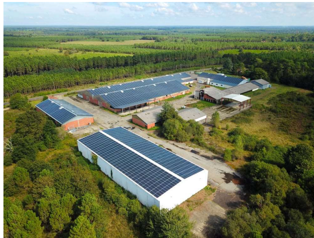
14. Exemple d'un projet de recouverture de bâtiments (source Amarenco)
