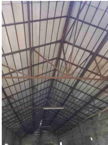
5. Plaques amiantées sous tuiles plates
