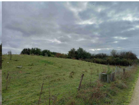
7. Merlons de terre pour protection des plateformes
