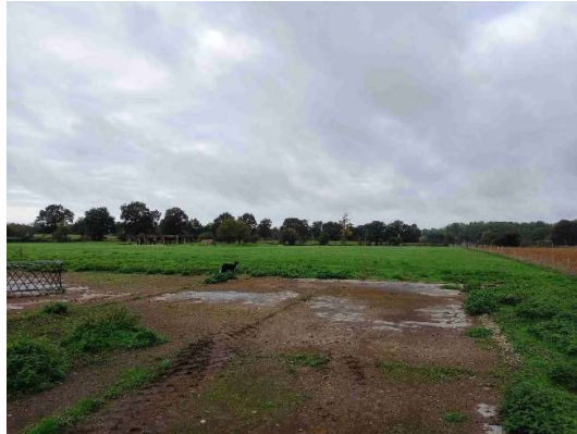
16. Prairie de parcours extérieur avec dalle béton et bâtiment non utilisé
