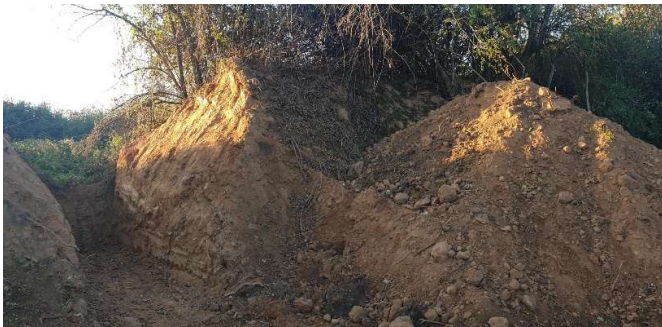
7. Merlons de terre pour protection des plateformes
