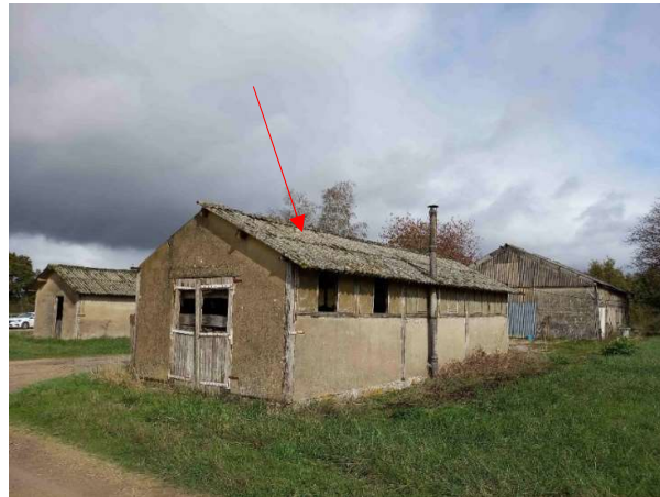
4. Couverture en fibrociment amiante
