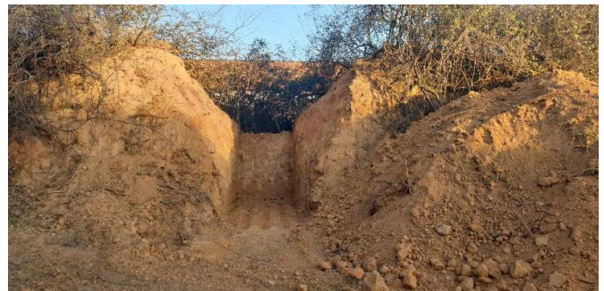
7. Merlons de terre pour protection des plateformes
